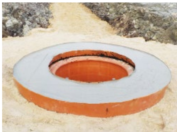
Рисунок: Фото формы под заливку опорного кольца №1 (ФБ1)
