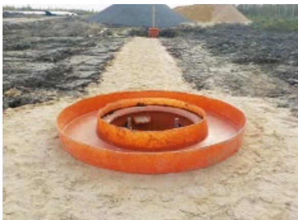
Рисунок: Фото формы под заливку опорного кольца №1 (ФБ1)
